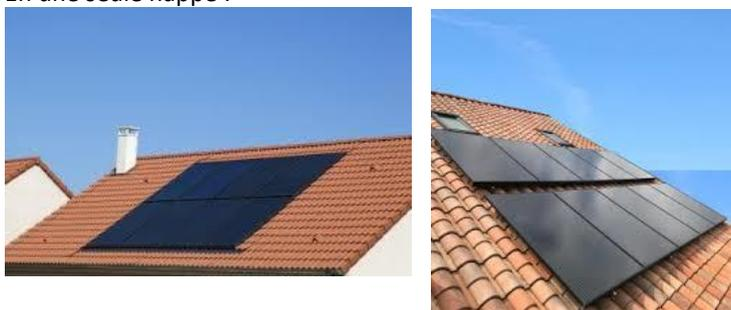
Deux nappes sont autorisées dans le cas d'une continuité dans la forme du toit mais avec un décroché de toitures :
